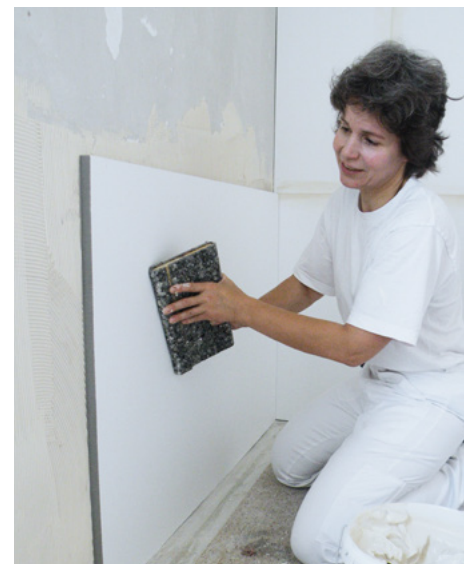
Innendämmung der Außenwand mit der Superwand DS.
